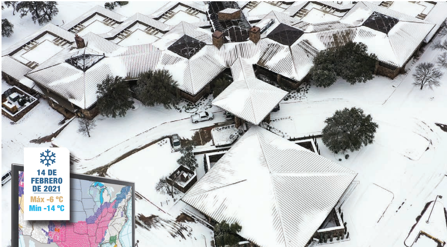
Edificio de la sede, febrero de 2021
